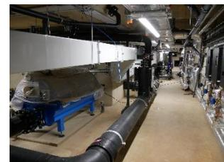
Auch die Schwimmbadtechnik entspricht dem neuesten Stand der Technik. Unter den Becken kommen neuartige Vorfilter zum Einsatz, die in Deutschland einzigartig sind. Ihr Vorteil: Der Energieaufwand der Sandfilteranlagen sinkt deutlich. Zudem wird das Chlor im Hallenbad über eine eigene Elektrolyseanlage selbst aus Salzen erzeugt und muss nicht aufwendig zugeliefert werden. Auch Chlorgase werden hierdurch vermieden.
